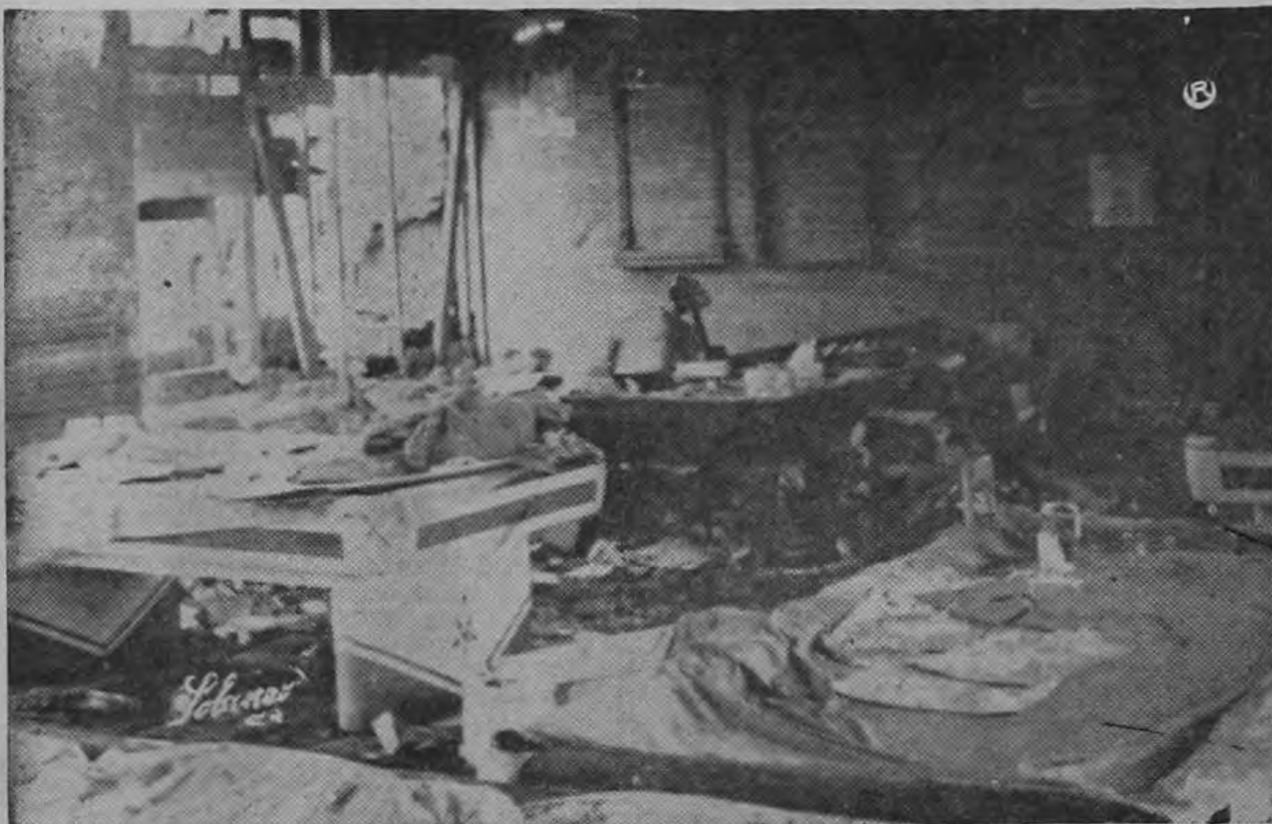
SALA DE BILLARES DESTRUIDA. Parcialmente fueron salvados los equipos en una sala de billares. Las mesas, de alto costo, sufrieron daños considerables. (Foto SOLANOV).
